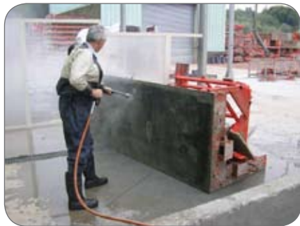
Décapage de banches métalliques
