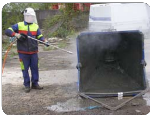
Décapage d'une bétonnière
