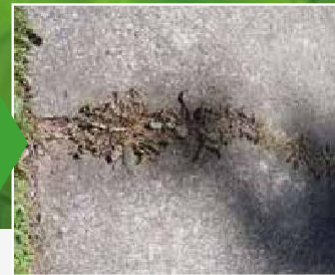
Mauvaises herbes sur le trottoir 2 - 5 jours après le traitement
